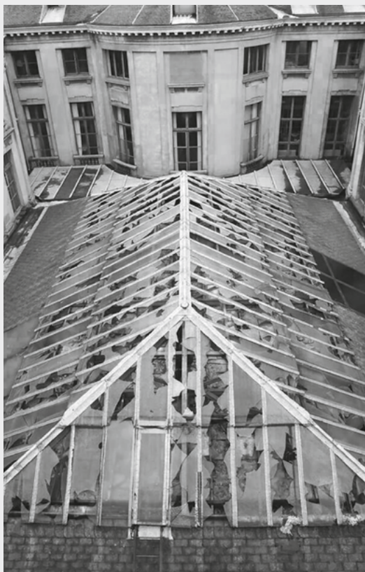
Hagelschade aan de beglazing van de overkapping van Studio Herman Teirlinck na het overtrekken van de supercel in 2014 (facebookpagina DE Studio)
