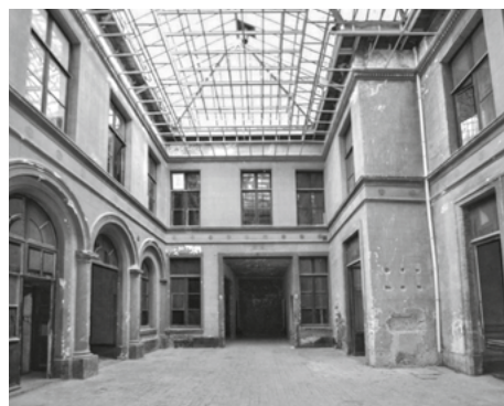
Foto uit 2014, met het gestripte gebouw toen het verkocht werd. De glastegels zijn verwijderd. Boven de roostering zijn de eenvoudige vakwerkspanten zichtbaar (immokantoor Heeren)
