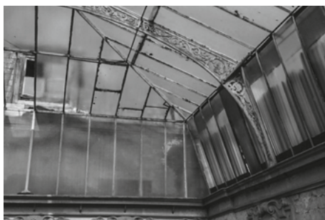
Detail van de overkapping met gietijzeren spant (foto R. de Beer)
