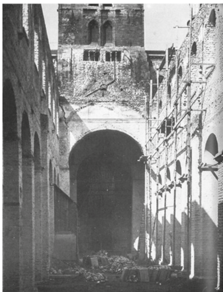
← Photo du mur oriental de l'avant-corps après le bombardement de 1940, avec la trace des anciens pignons dont celui correspondant à une charpente d'une couverture en tuiles. (photo : J. Mertens).
