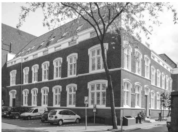
Het Bossche redemptoristenklooster aan de Sint Jozefstraat te 's-Hertogenbosch is na leegstand en brand na 1985 herbestemd tot sociale huurwoningen (particuliere collectie)
