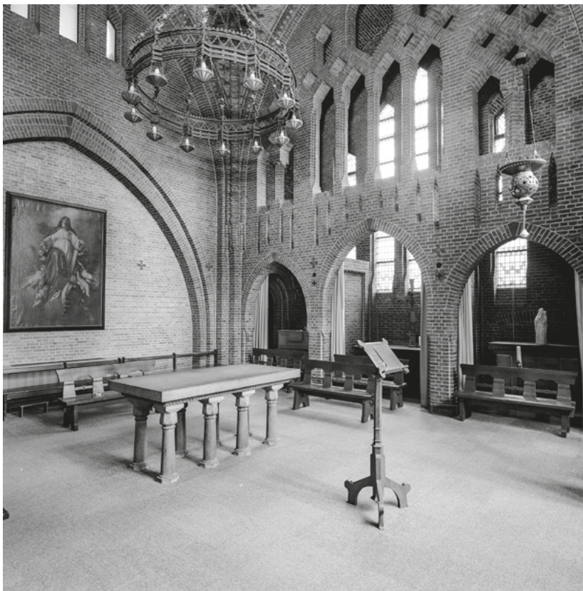
De congregatiekapel van de door Dom. Paul Bellot in expressionistische baksteenstijl gebouwde Paulusabdij in Oosterhout (Rijksdienst voor het Cultureel Erfgoed)
