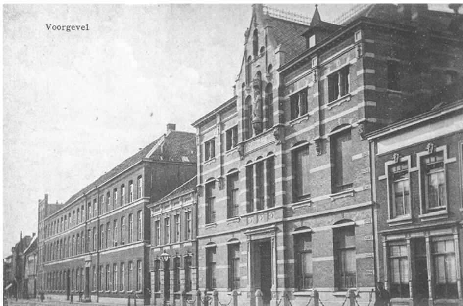
De voorgevel van pensionnat Sainte Marie, circa 1910 (Atelier Quadrat, Kloostercomplex Mariadal , 14)
