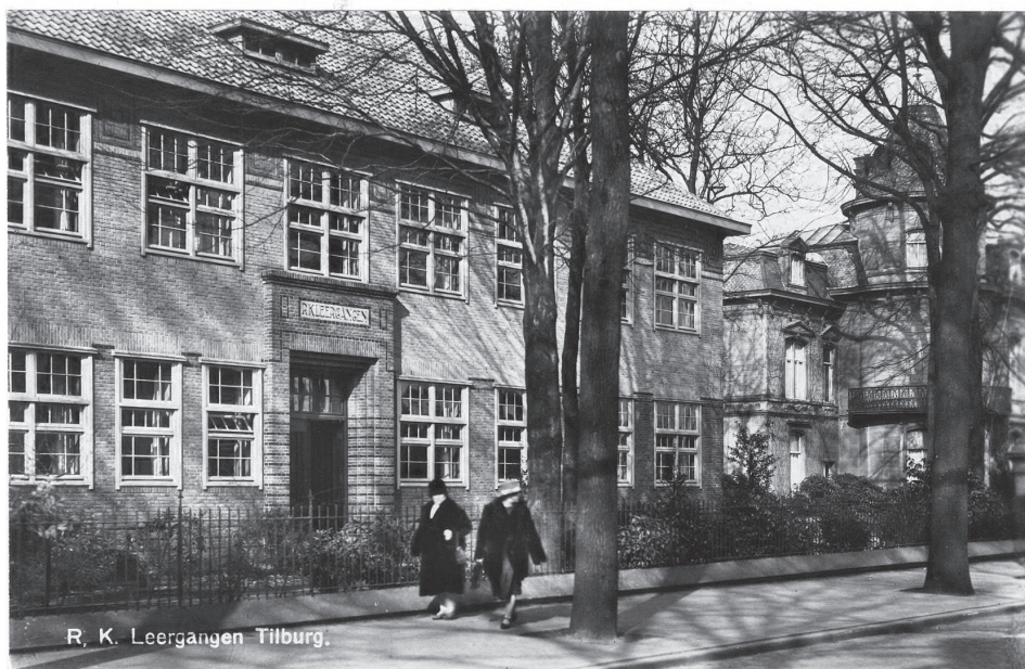
De Rooms-Katholieke Handelshoogeschool woonde vanaf de oprichting in 1927 tot 1962 in bij de Rooms-Katholieke Leergangen aan de Tivolistraat in Tilburg (Collectie Fotoarchief Universiteit van Tilburg)
