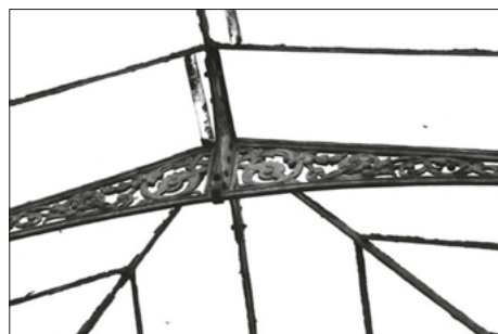
Detail van het bijzondere gietijzeren spant (foto F. Janssens)
