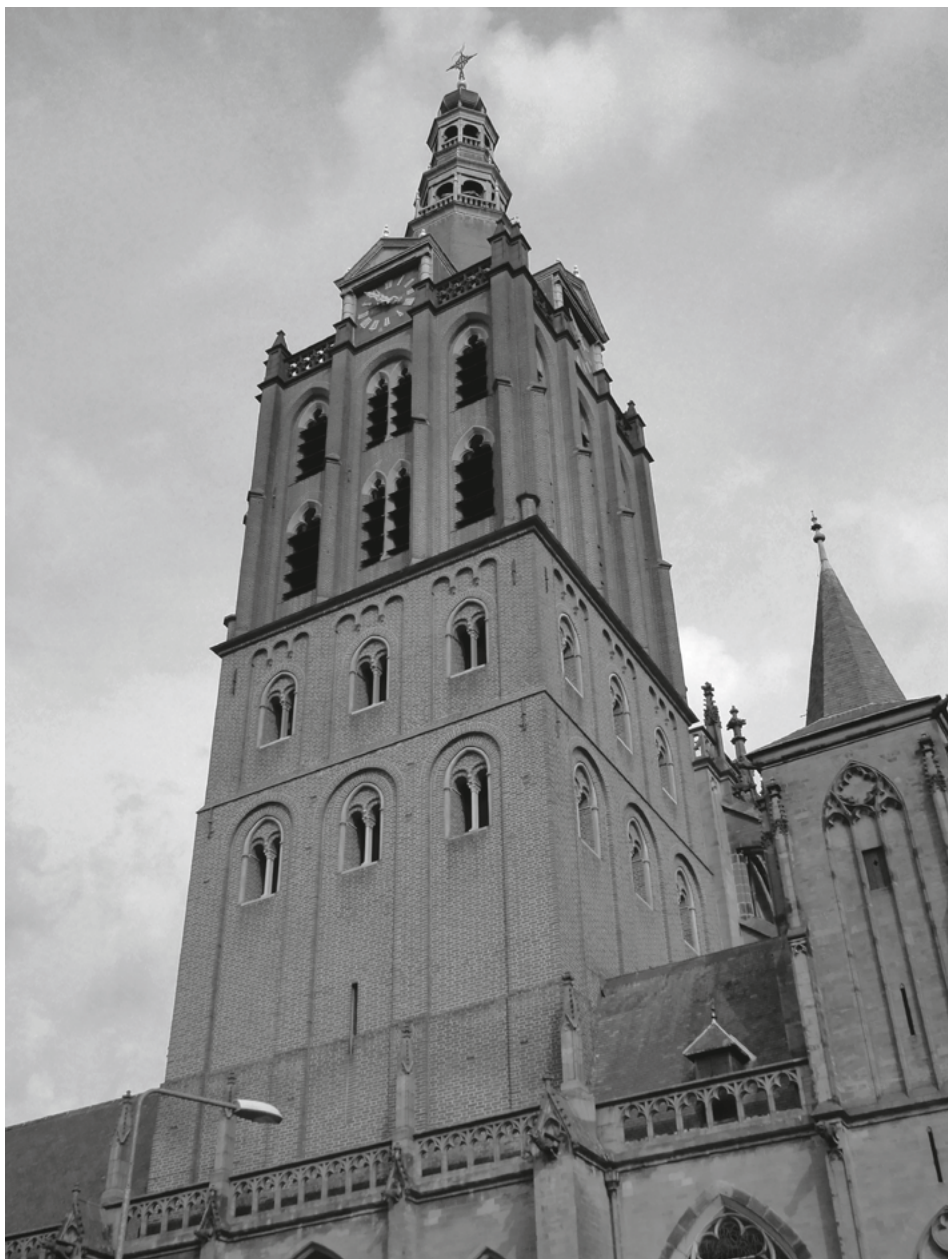
De onderzijde van de toren van de Sint-Jan in 's-Hertogenbosch, het oudste en enig overgebleven romaanse deel van de kerk uit de dertiende eeuw (rijksmonumenten.nl)
