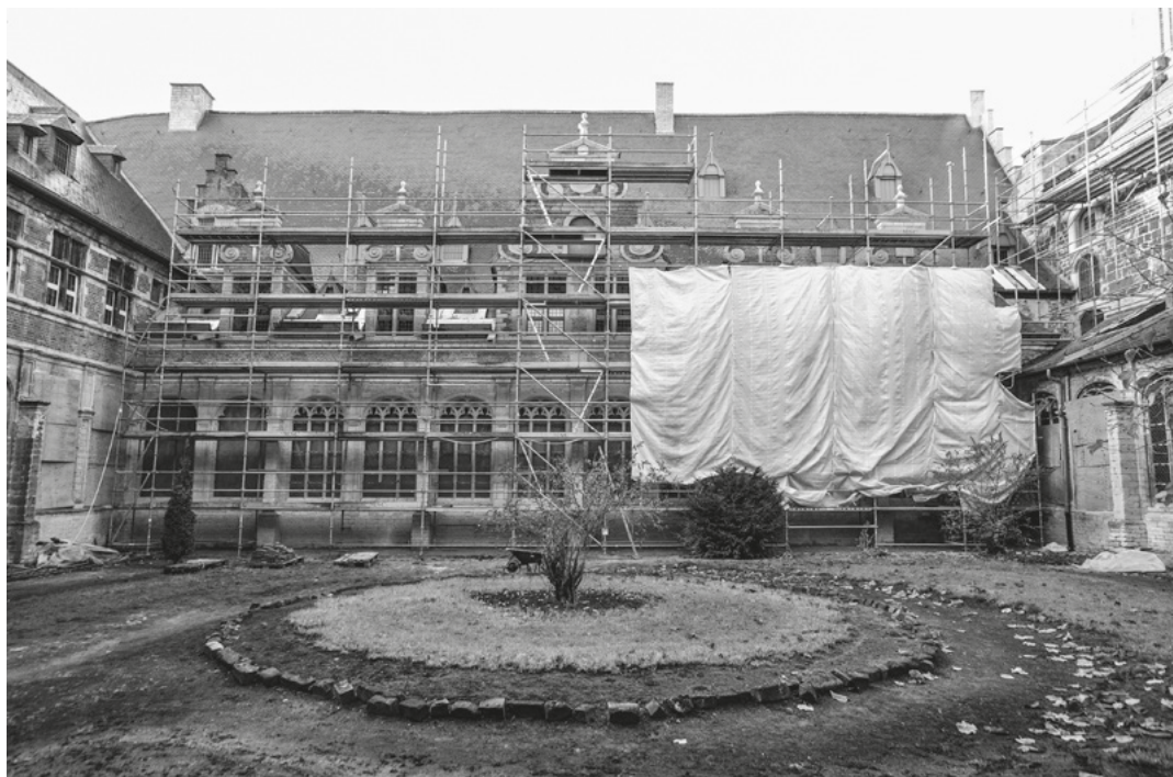
Travaux de restauration autour le jardin du cloître de l'Abbaye du Parc à Heverlee (collection de photos de l'Abbaye du Parc)
