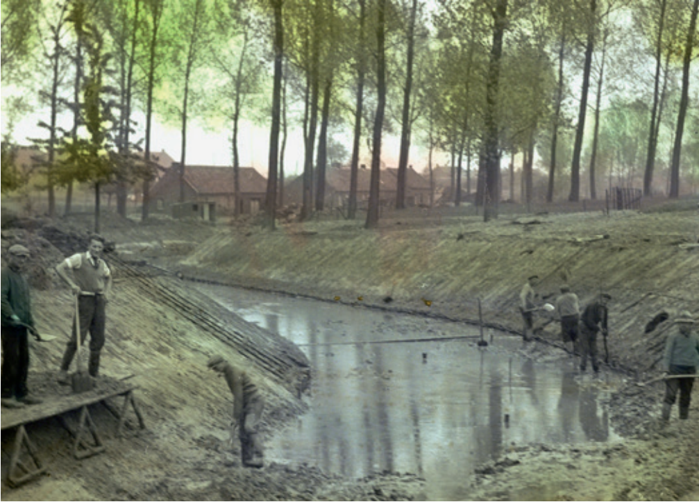
Afb. 18 De kanalisatie van de Haelense Beek in 1935-1936. De beek is in 2016 weer in meanders gelegd. Glasdia Nationaal Archief, Fotocollectie Nederlandse Heidemaatschappij, nr. 193-1141.
