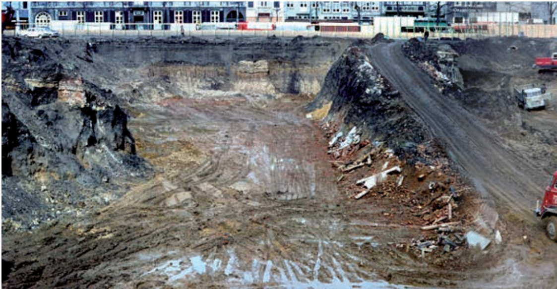
De enorme kuil die nodig was voor de Vrijthofgarage, tijdens de ontgraving. Firma Langen uit Geleen voerde de grond af. Aan de noordelijke wand 'hangt' de Romeinse kelder nog in het profiel. Foto ROB 1969-1970, afkomstig uit opgravingsdocumentatie Vrijthofonderzoek 1969-1970, in beheer bij Gemeente Maastricht/Centre Céramique.
