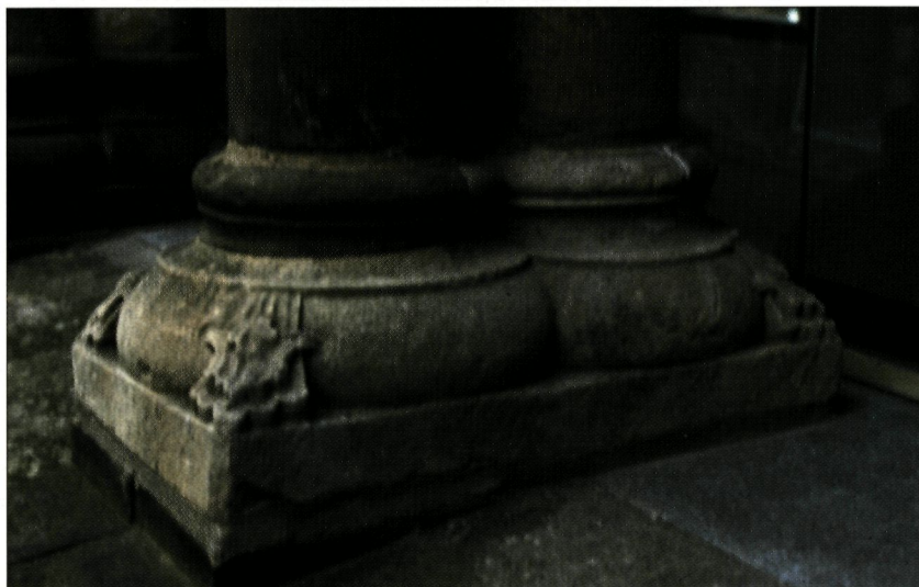
11. De oostzijde van basement B2. Aan de bovenzijde zijn links en rechts grote stukken nieuw ingezet.
