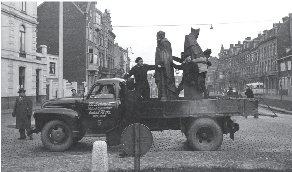
De standbeelden van Lambertus en Hubertus worden gezamenlijk aangevoerd op de vrachtwagen van Dotremont, bij de bouw van de Mariazuil op het kruispunt van de Wilhelminasingel en de Stationsstraat te Maastricht (foto RHCL, collectie GAM 3541).
