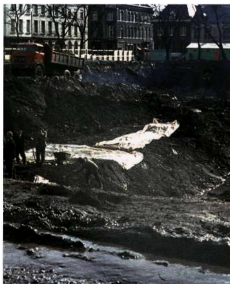
Afb. 19. Start van het grondwerk voor de parkeergarage onder het Vrijthof, terwijl de opgraving nog niet is afgesloten (begin 1970).
