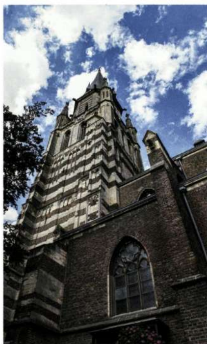
Toren van de laatmiddeleeuwse Petruskerk. Het onderste deel van de toren werd begin zestiende eeuw gebouwd (foto Vic Hendriks).
