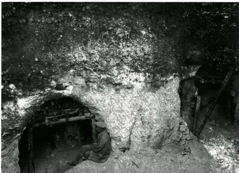
Fig. 4. In het laatste jaar van zijn onderzoek in Rijckholt (1926) ontdekte Van Giffen enkele schachten en galerijen. Tegen het instortingsgevaar werden ze gestut met hout dat in het Savelsbos werd verzameld. Toch was de situatie zo gevaarlijk dat hij een verbod kreeg verder te graven (foto particuliere collectie).
