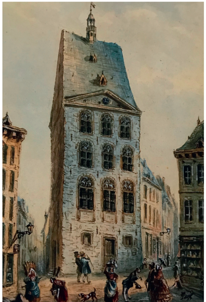
p10: in november [1749] is het portaal van het oude stadhuijs afgebroken (bedoeld is de dingbank in de Grote Staat) van Maastricht. In de gevel links werd een jaartalsteen 1749 geplaatst. Aquarel uit ca. 1860 toegeschreven aan J. Lefebvre in: Ach Lieve Tijd, Twintig eeuwen Maastricht , Zwolle 1994, pag. 37.
