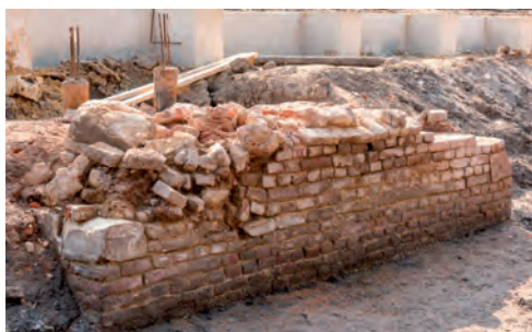
Afb. 47 Detail bruggenhoofd. De aanzet van de boog is nog zichtbaar.
