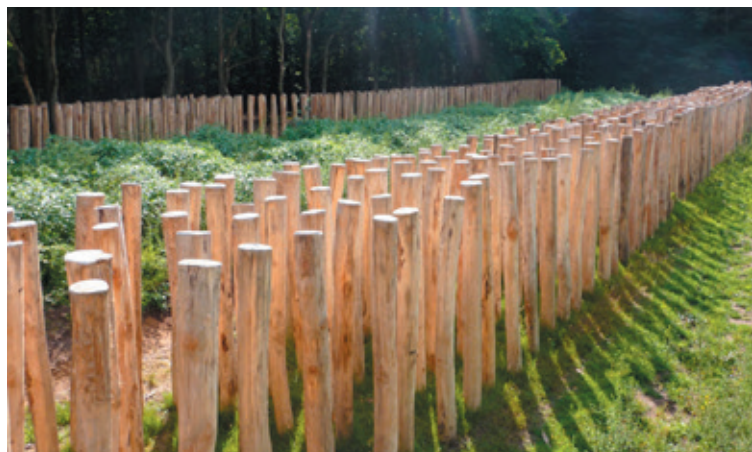
Afb. 19 In het Bomenpark in Heesch is een 65 meter lange reconstructie van de landweer gemaakt, met palen, wallen, greppels en heesters (ontleend aan https://www.allemaalmaas-horst.nl/landweer-bomenpark-heesch ).
