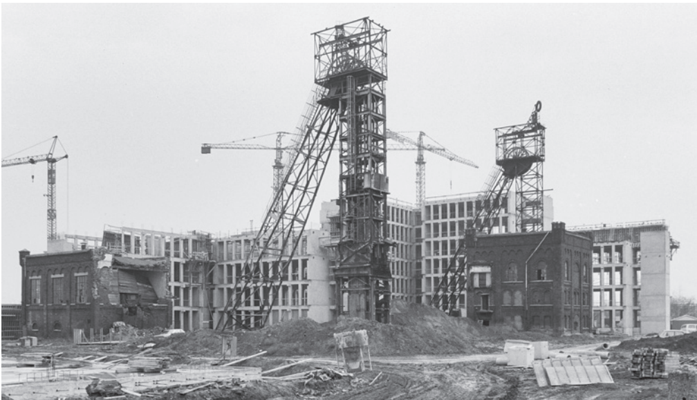
Afb. 13 De sloop van de bovengrondse gebouwen van de mijn Oranje-Nassau I in 1977. De beide kasteelachtige gebouwen bleven gespaard. Het rechter gebouw is nu mijnmuseum. Foto: Beeldbank Rijksdienst voor het Cultureel Erfgoed, Amersfoort, nr. 192021.
