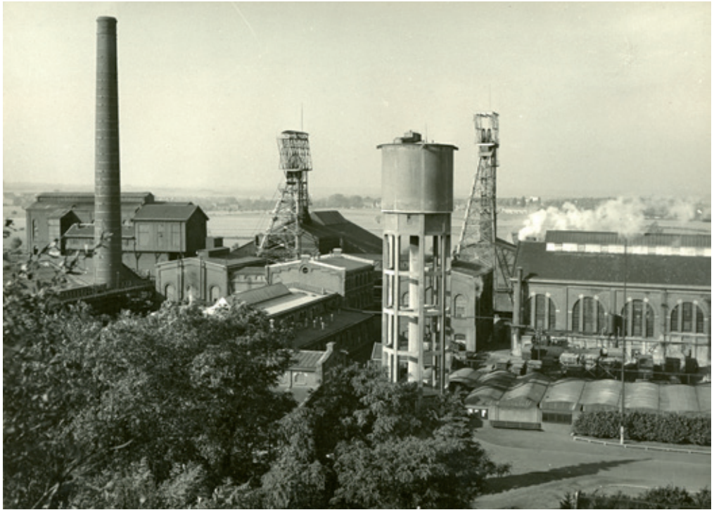
Overzicht Oranje-Nassau Mijn II in Schaesberg met de schachten I en II. In deze mijn waren tussen juni 1946 en augustus 1949 niet-bonafide Duitsers ondergronds tewerkgesteld. Historisch Centrum Limburg / DSM voorlichtingsdienst (fotografieafdeling), foto 15 april 1947. Fotocollectie DSM, HI 2702-2333. CC BY-NC-SA
