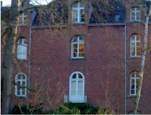
Abb. 30 Nordfassade Schloss Ottenfeld (Foto B.L. 2022).
