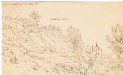
Afb. 24 'Geteeckent bij Maestricht, den 6 may 1671. Slavanten Clooster'. Tekening van de oostelijke helling, vanuit het zuiden, door Josua d Grave. HCL, Collectie LGOG, nr. 84.
