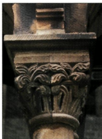
12. De westzijde van K3. De rechterhoek van het kapiteel is geheel nieuw.
