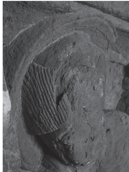
Afbeelding 13: detail van het Loonse timpaanfragment. Hoewel de figuur zwaar is beschadigd, is nog duidelijk te zien dat hij een tonsuur heeft.
