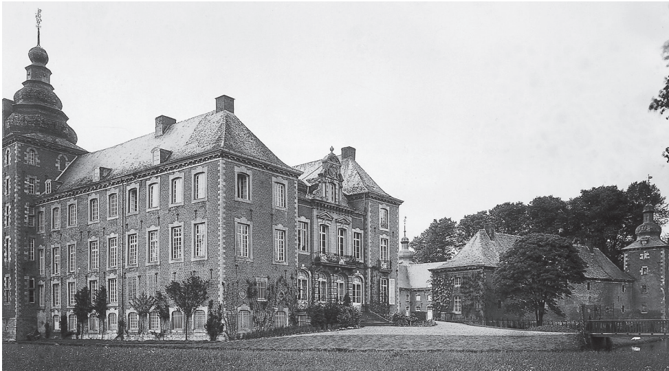
Neubourg vanuit het zuidoosten in 1917. De restanten van de geschilderde schijnvensters zijn nog duidelijk herkenbaar. Let op het hoogteverschil van het terrein tussen zuid- en noordzijde. Foto C. Steenbergh. RCE.
