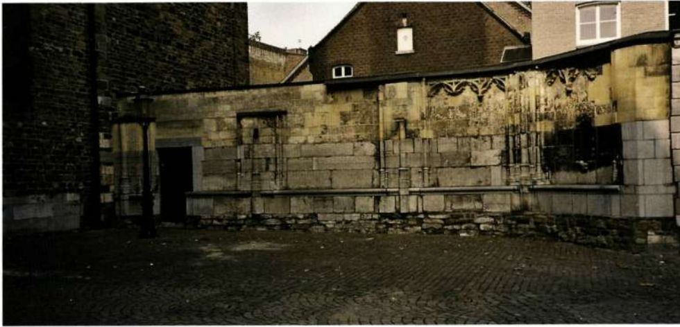
Afb. 3: Sint-Servaas, Noordmuur van de Koningskapel, Maastricht, 1463-1804 (foto auteur)
