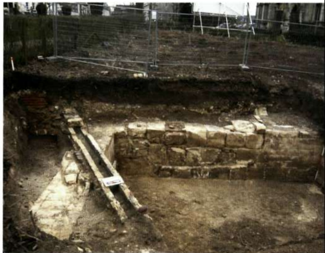
Afb. 16. Meerssen, Proosdijpark. Overzicht van werkput 2 gezien naar het oosten, met muurwerk uit de 16 e tot en met de 18 e eeuw (Hazen 2012, afb. 12). Foto © ADC.
