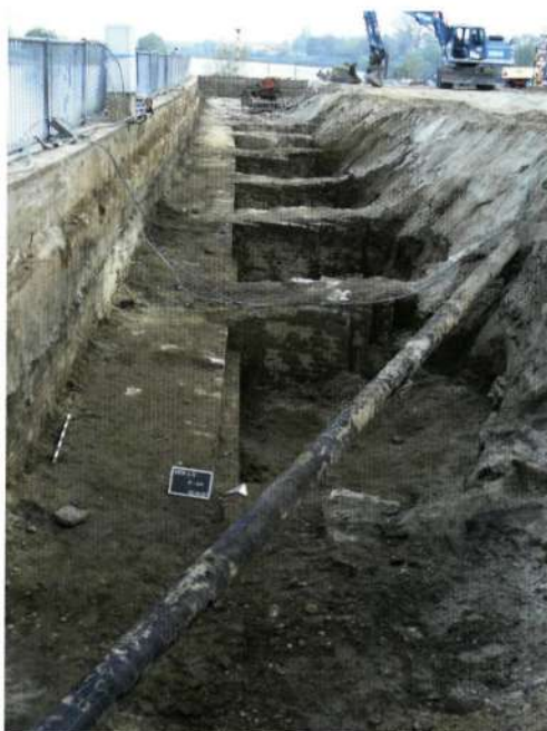
Afb 4. Heraanleg Maaskaden, Venlo, kadevak KA. De 19 e eeuwse muur, noord-zuid georiënteerd met een lengte van 56,8 m. en een breedte van 1,3 m., is opgetrokken uit baksteen. Aan de binnenzijde van de muur zijn om de 3,5 m. zware steunberen geplaatst die in verband met de muur zijn gemetseld (Weiss-König & Loonen 2012, fig. 5.11). Foto © Archeodienst.
