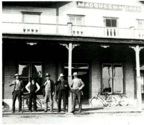
In Miles City logeerde Edmond in het Macqueen House. Dit hotel zou twee jaar later afbranden.
