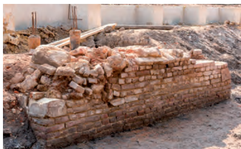
Afb. 47 Detail bruggenhoofd. De aanzet van de boog is nog zichtbaar.
