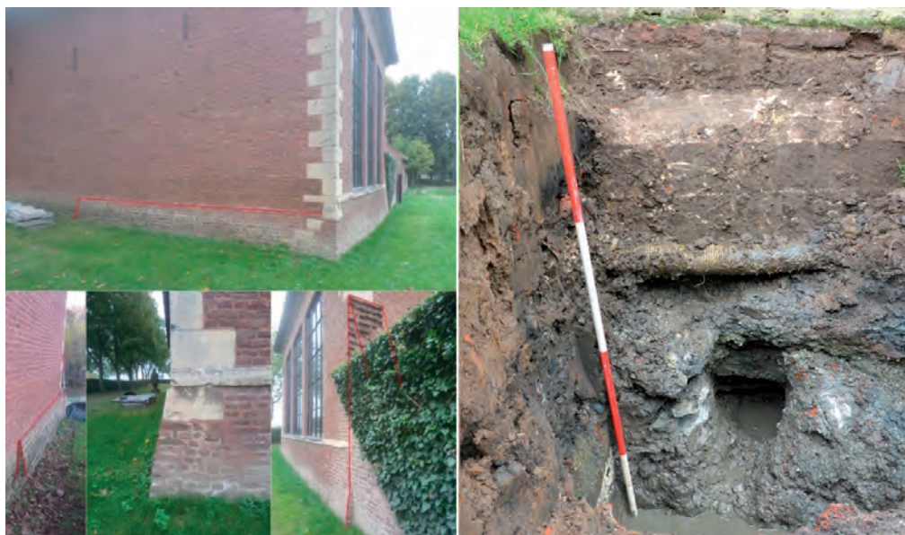
Afb. 43 Links: aan de noordelijke zijde van de oostgevel is een merkwaardige verbreding van de fundering herkenbaar. Mogelijk betreft dit het gedeelte dat in de voormalige grachtvulling op palen is gefundeerd. Rechts: De fundering van het Etzenrader Huusken waar de houten ligger nog net herkenbaar is.
