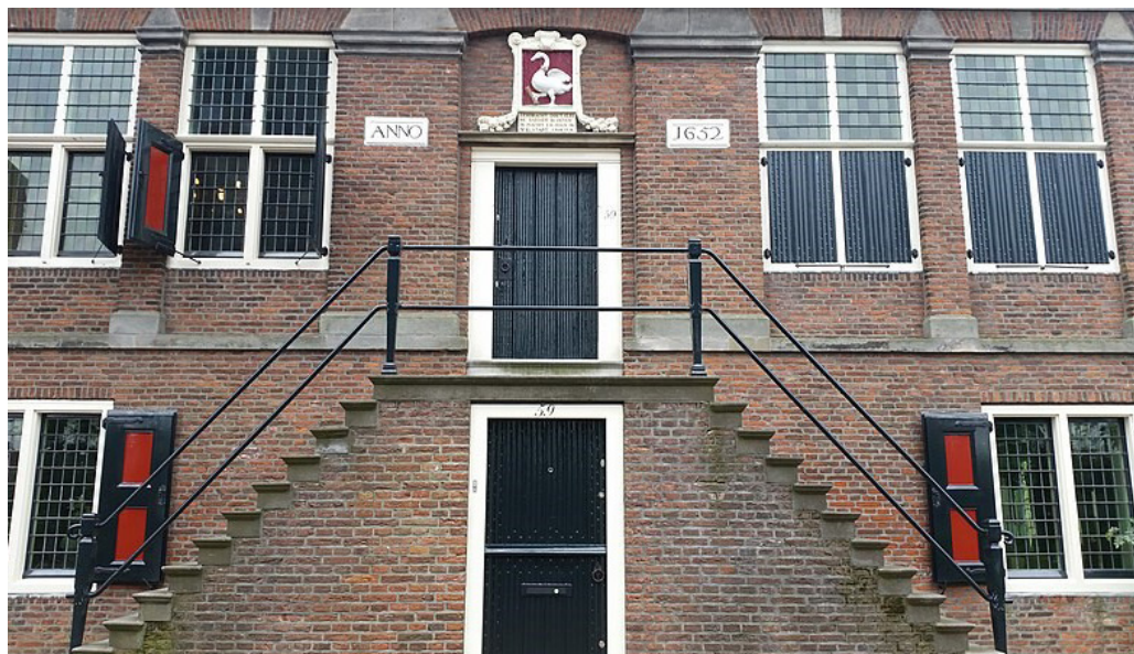
Figuur 1: In 1652 kozen de Waterlandse dorpen het net gebouwde raadhuis van Ransdorp als vergaderplaats. Van-daag de dag prijkt het wapen van Waterland, een zwaan, nog steeds op de gevel. De pijlen die hij in zijn poot houdt, verwijzen naar de zes hoofddorpen van Waterland. De tekst onder de zwaan verwijst naar de Waterlandse Unie: 'Een-dracht doet cleyne saecken bloeyen in macht en oock in welstant groeyen'.
