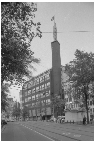
Het Telegraafgebouw. Bron: Stadsarchief Amsterdam.
