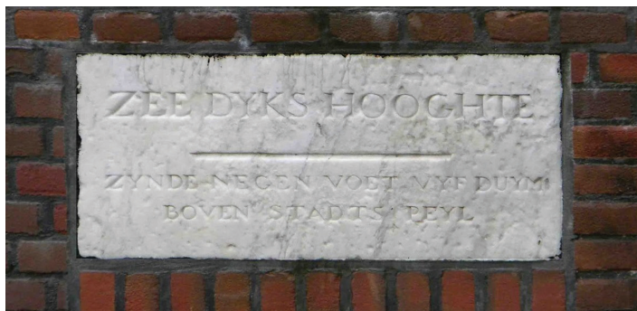
Fig. 4: Een 'Huddepeilsteen' opnieuw ingemetseld in de Nieuwe Brug (Damrak-Prins Hendrikkade), na alle veranderingen in verband met de aanleg van de Noord-Zuidlijn. Opschrift: 'ZEEDYKS HOOGHTE, ZYNDE NEGEN VOET VYF DUYM BOVEN STADTS PEYL.'
