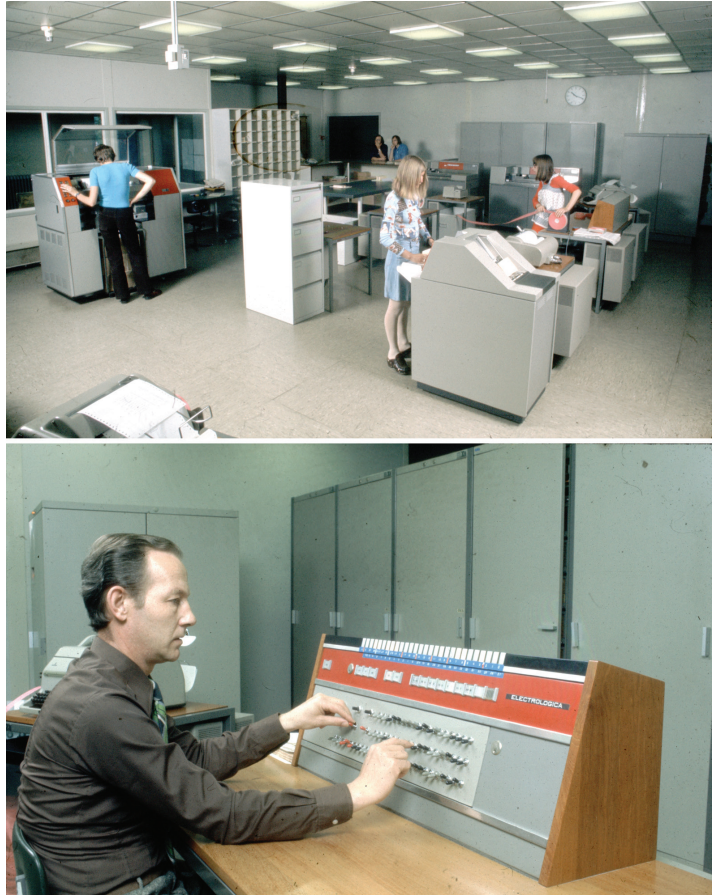
Fig. 10: Boven: Electrologica X8 in het rekencentrum van Philips Natlab. Onder: aan de console Ad Dekkers. Foto's Collectie Zonneveld.
